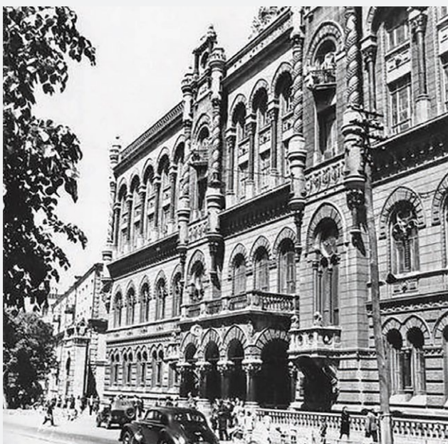
Будівля після реконструкції у 1934 році
